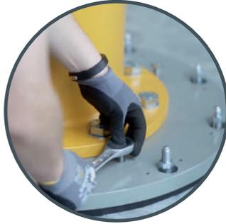
**Alignement rapide et simple** de la plaque à cheiller par les vis de réglage intégrées
