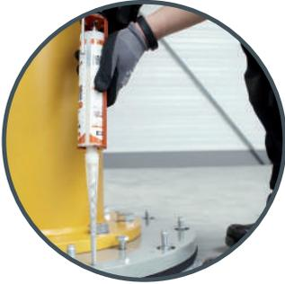
**Compensation rapide des dalles inégales (max. 15 mm)** par une surface définie et élastique avec des amortisseurs – sans calage. Les amortisseurs sont remplis avec un mortier spécial qui durcit rapidement et permet une charge de pression régulière et la mise en service immédiate.
